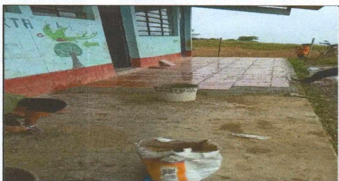
Foto 5: SUSTITUCION DE PISO
