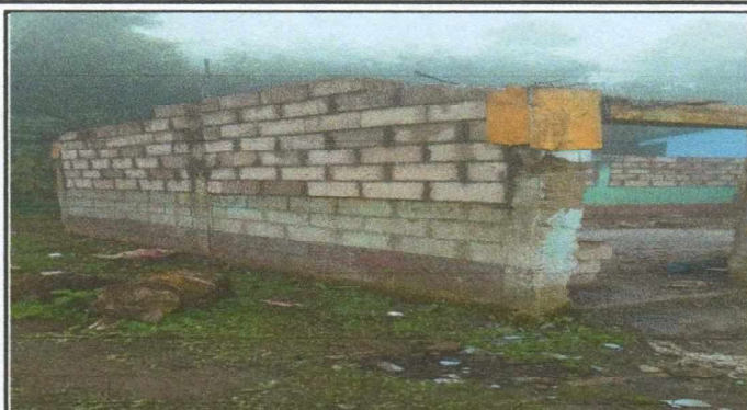
Foto 2: SUSTITUCION DE PAREDES DE COCINA
