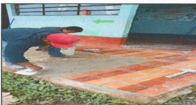
Foto 6: SISTITUCION DE TORTA DE CEMENTO POR PISO CERAMICO
