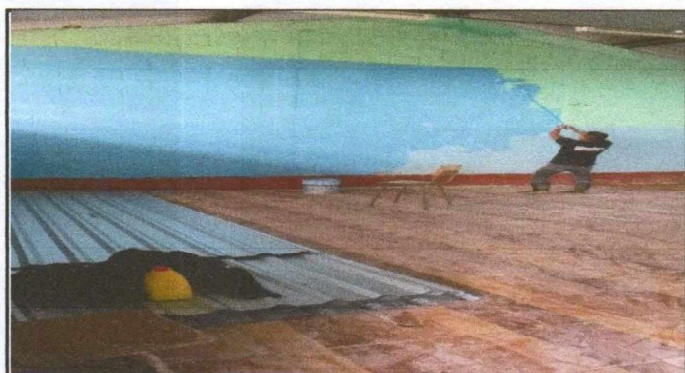
Foto 3: SUSTITUCION DE PINTURA DE PAREDES
