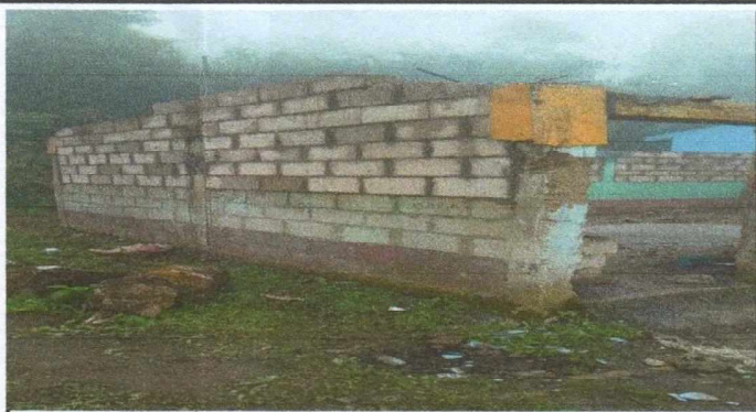
Foto 1: SUSTITUCION DE PARED DE COCINA
