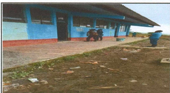
Foto 4: SUSTITUCION DE PINTURA DE PAREDES
